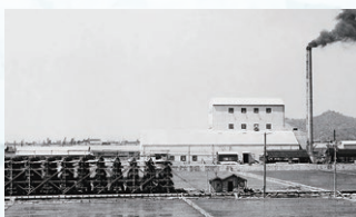
最新式の流下式塩田を導入。枝条架と呼ばれる竹の枝を付けた槽がシンボル
